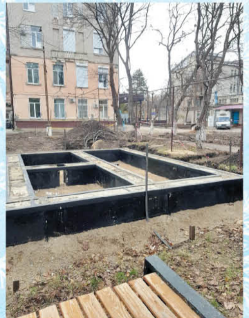
Подготовительные работы по установке новой трансформаторной подстанции
